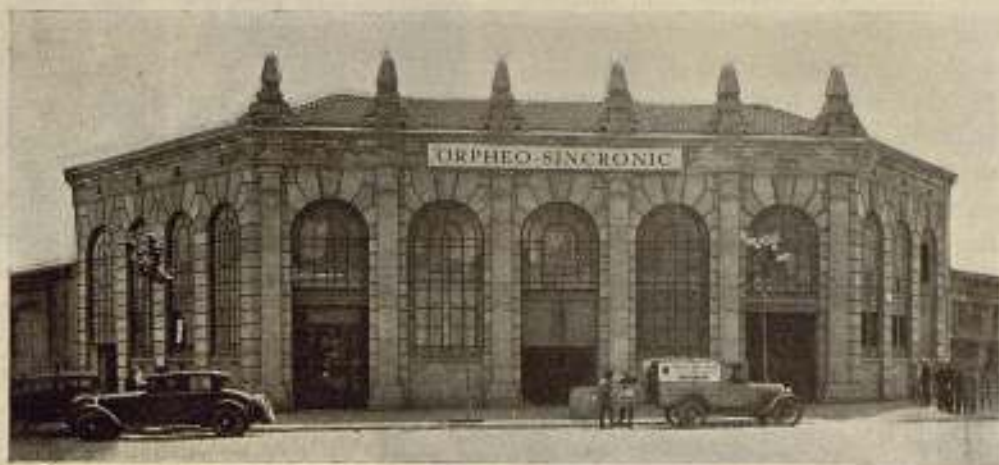
Fachada de los talleres
