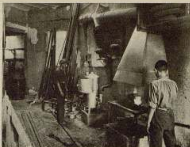
Sección de fregado y forja
