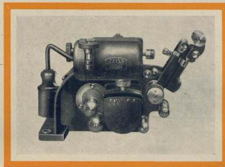
Este modelo posee las mismas ventajas que el dispositivo C, pero no está equipado con motor sincronizado y transmisión - La conducción de la película a través del dispositivo sonoro D se efectúa por medio del proyector - Por consiguiente, la calidad del sonido depende en gran manera de las características del proyector, así como también de la marcha constante del motor que se emplee.
