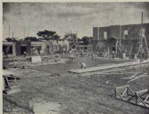
Montaje de decorados rígidos al aire libre. No se diferencia en nada de los mejores «in the works»
