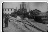
S.2.08. INAUGURACIÓN DEL TRAMO GALLUR-EGEA DE LOS CABALLEROS DEL FERROCARRIL SÁDABA-GALLUR
