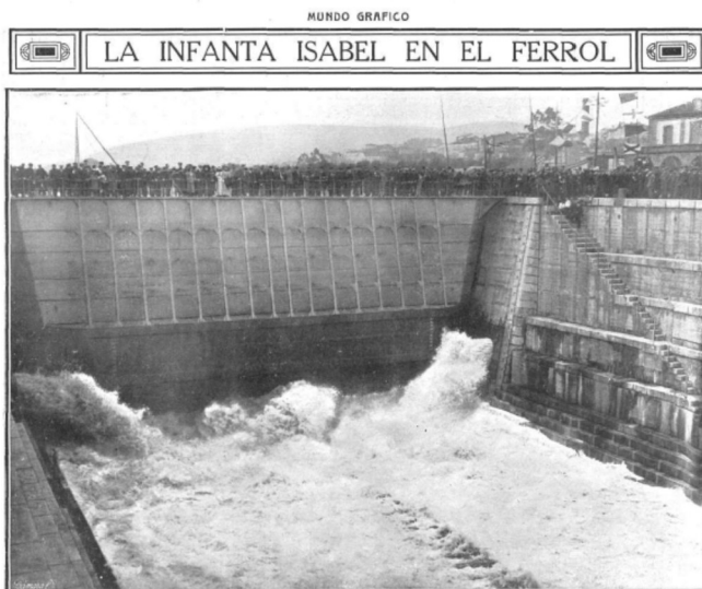
El dique Reina Victoria Eugenia, cuya inauguración se ha verificado en presencia de S. A. la infanta Doña Isabel. Momento de dar entrada a las aguas
