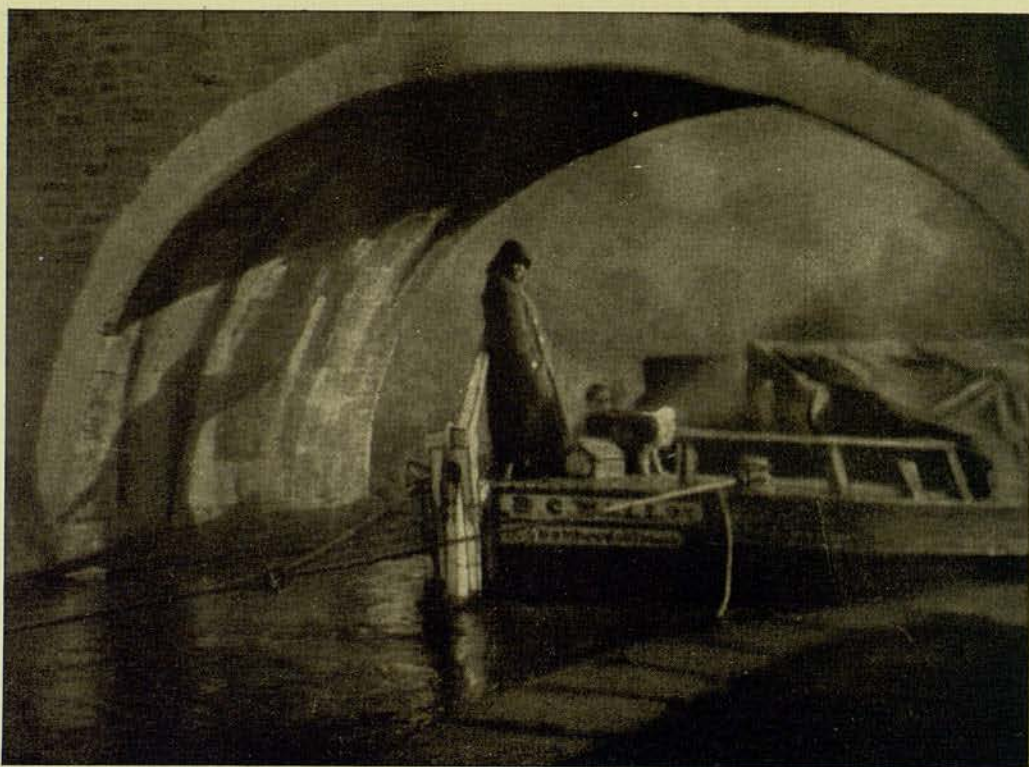
EL PONT DEL CANAL CARBO
