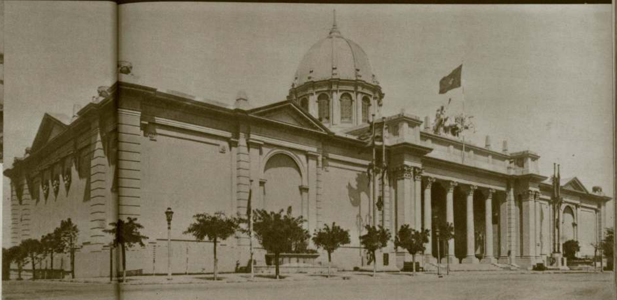
Vista general de los Estudios «Orpheo» destruidos parcialmente por un incendio que ocasionó pérdidas cuantiosas. La parte derecha del edificio, en la que estaba instalado el gran «plateau», fue la que sufrió las consecuencias del siniestro, en el que perdió la vida un obrero y en el que sufrieron heridas de consideración dos de los carpinteros que trabajaban en el montaje de los decorados de «María de la O», film que se estaba rodando en estos estudios.
