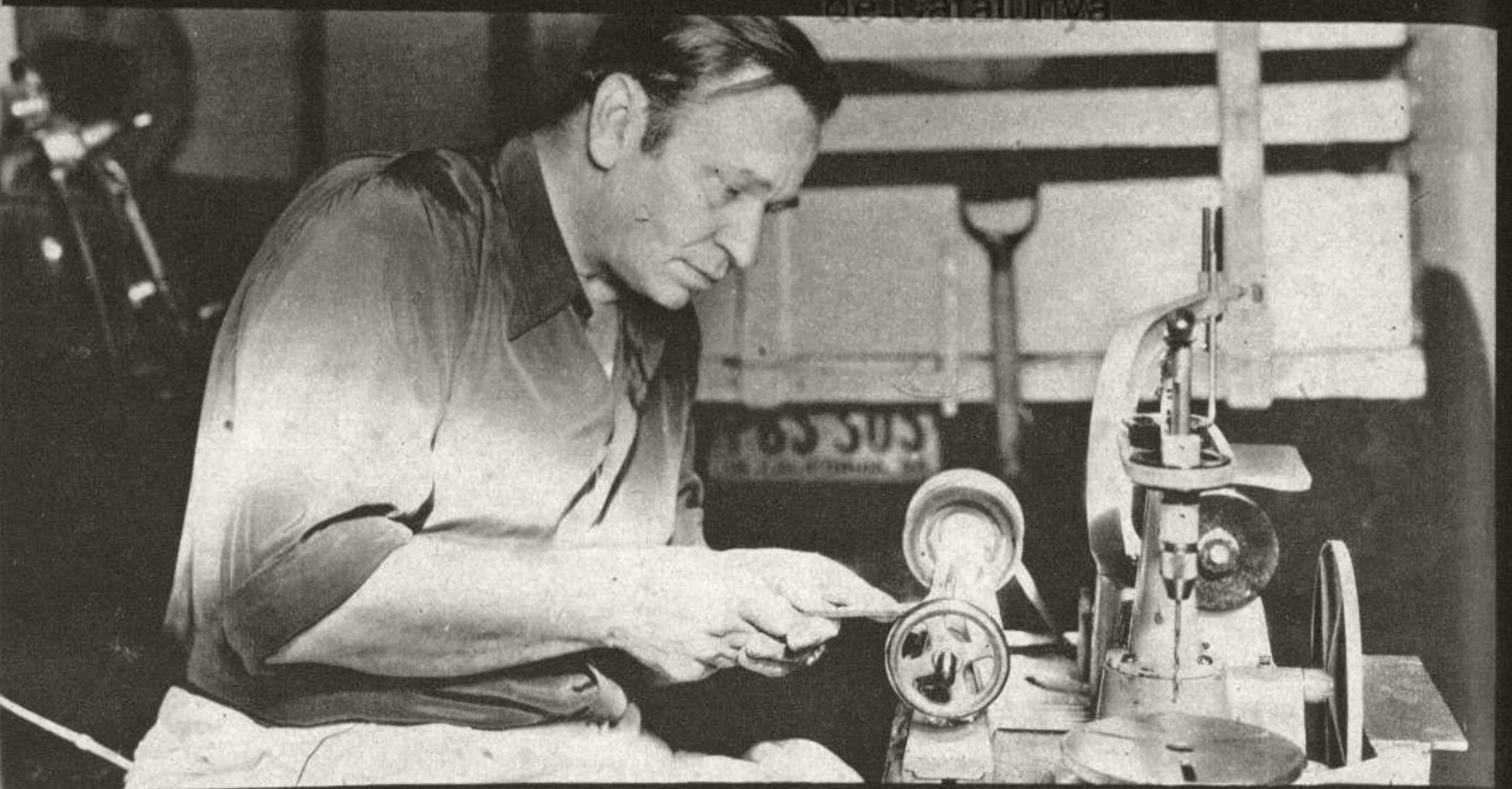
Wallace Beery, con la máquina que acaba de adquirir para su taller. Es una combinación de torno, taladradora, prensa, alisadora, sierra y amoladora.
