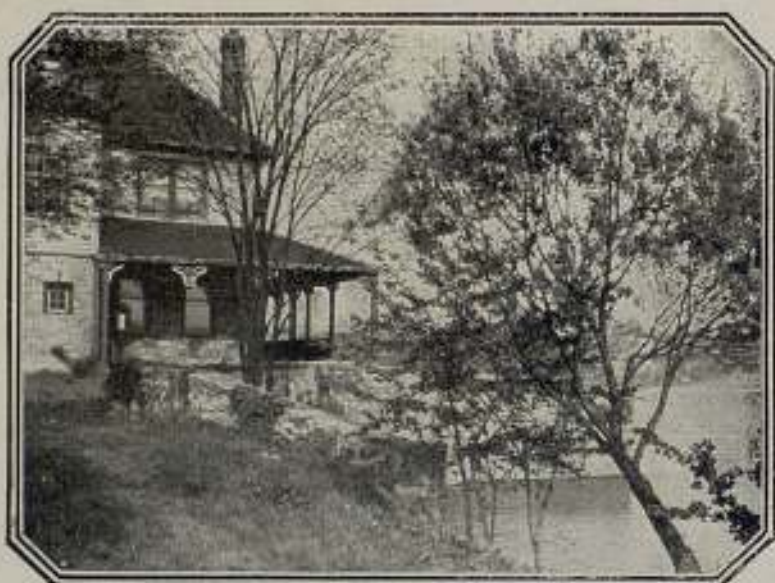
Torre donde están instaladas las oficinas de la Dirección de la manufactura
