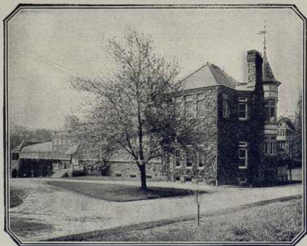
Edificio de la manufactura
