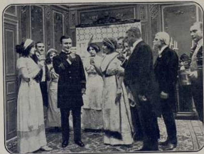
YDA NIELSEN.— Bon destructora
