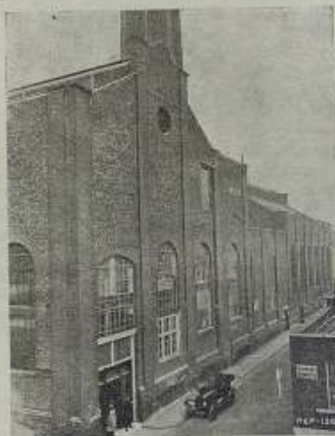
Vista exterior del estudio cinematográfico, que la empresa posee en Londres, para la producción de las películas «Paramount». Es el estudio más moderno y el mejor equipado que existe en Inglaterra. Las instalaciones eléctricas son la última palabra en cinematografía, existe en él un sistema de ventiladores para la purificación de la atmósfera, lo cual se había considerado siempre como el mayor inconveniente a causa de la constante neblina que invade a Londres.
