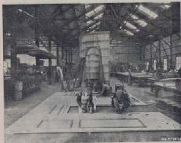
Los carpinteros del estudio «Lasky» dando los últimos toques a los muros laterales de una decoración que después de pintada y adornada formará una sección de un cuarto completo para una película «Paramount».
