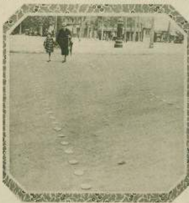
Discos indicadores puestos en los pasos de París, para proteger el paso de los transeúntes. Estos discos, cuya colocación fue ordenada por el Prefecto del Sena, están hechos de una aleación de hierro y cobre que conserva su brillo en todo tiempo.
