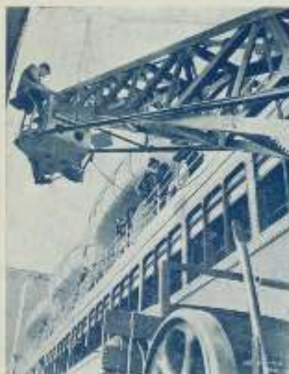
Una grúa gigantesca con su cabina de tomas de vistas
