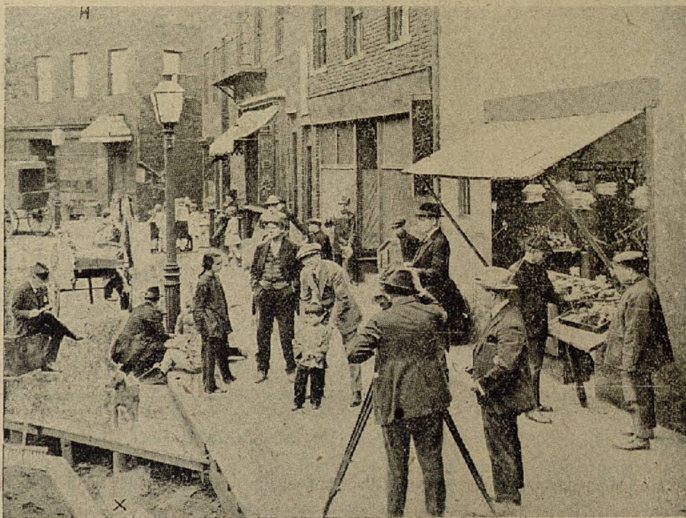
Toda esta calle, con sus tiendas, sus faroles, etc., ha sido construída para hacer una película. Véase (X) donde empieza la construcción
