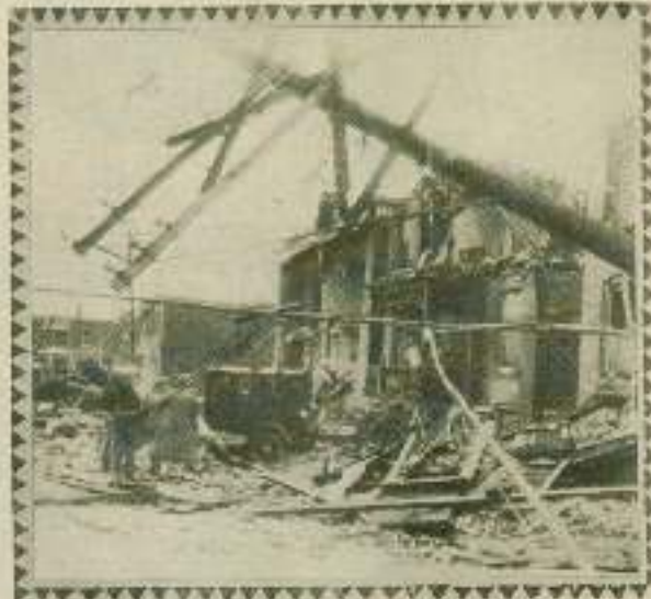
El último conado que combatió a la impetuosa ciudad de San Luis, la más populosa del estado de Misouri fue realmente horrible. Muchos edificios de esa zona ha sufrido sus ruinas, pero desde hacía años no se registraba un número de edificios tan destruidos. La fotografía que publicamos dará una idea al lector de los daños causados por el conado.
